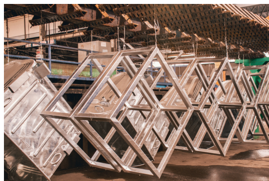
Galvanisering. Stålkonstruktioner der hænger til tørre efter at være dyppet i et galvaniserende zinkbad. © Shutterstock.
