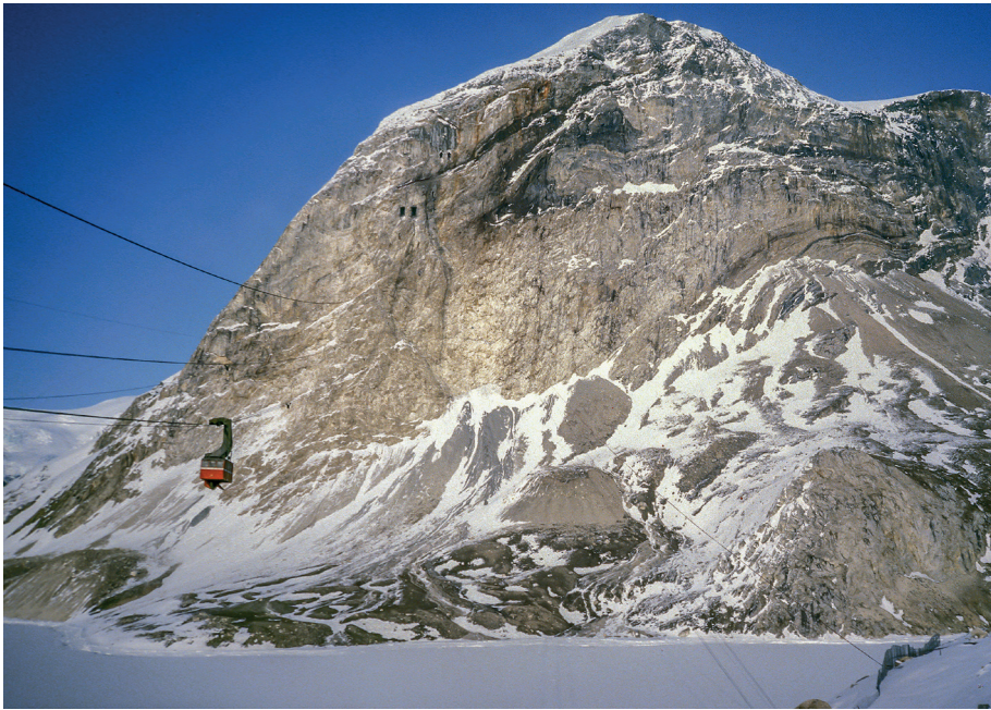
Minen Den Sorte Engel i Nordvestgrønland. Bemærk kabelbanen der fører op til mineskakt på fjeldsiden. I 1973-1991 blev 11,3 mio. ton Zn-Pb-Ag-malm udvundet fra denne mine. © Bjørn Thomassen.
