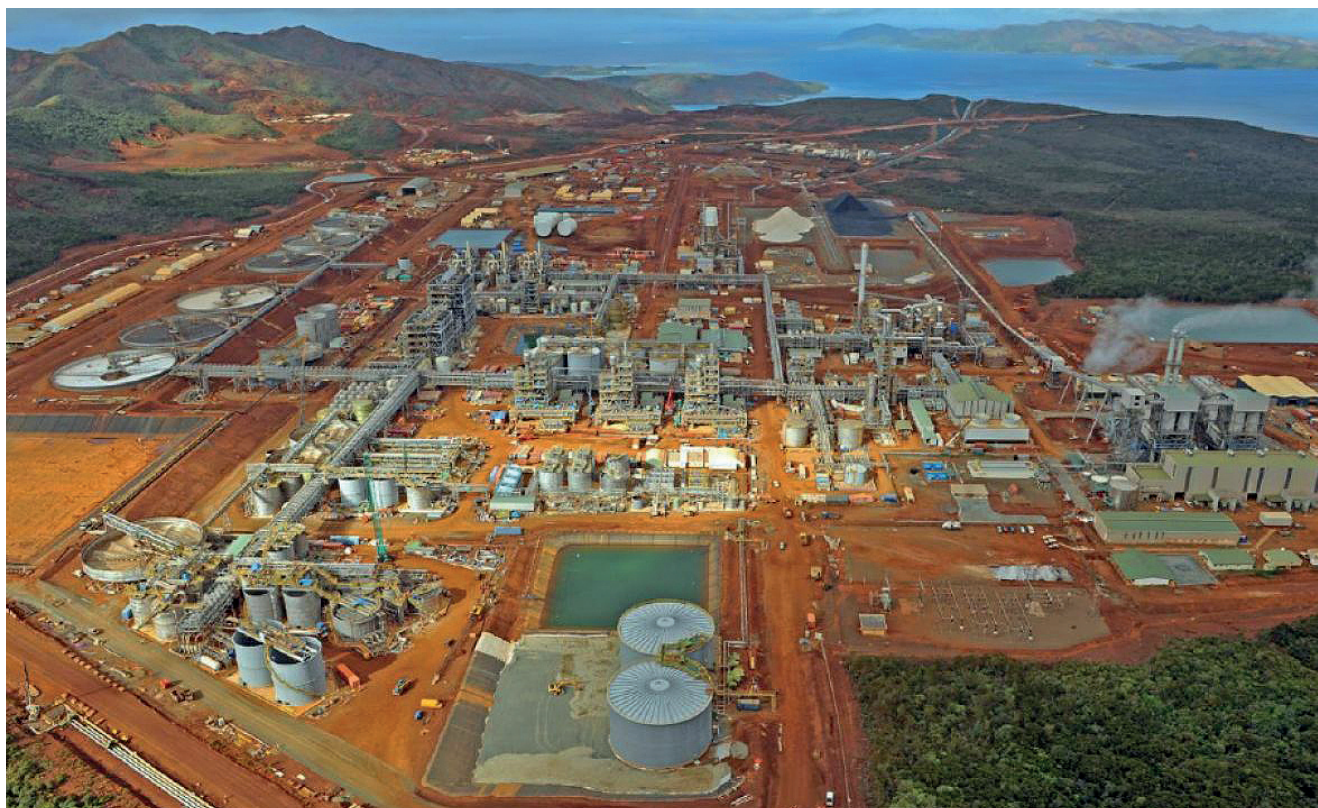
Goro oparbejdningsanlæg i Ny Kaledonien. Nikkel udvindes fra laterit-malm. Kilde: Canadian Mining Review.
