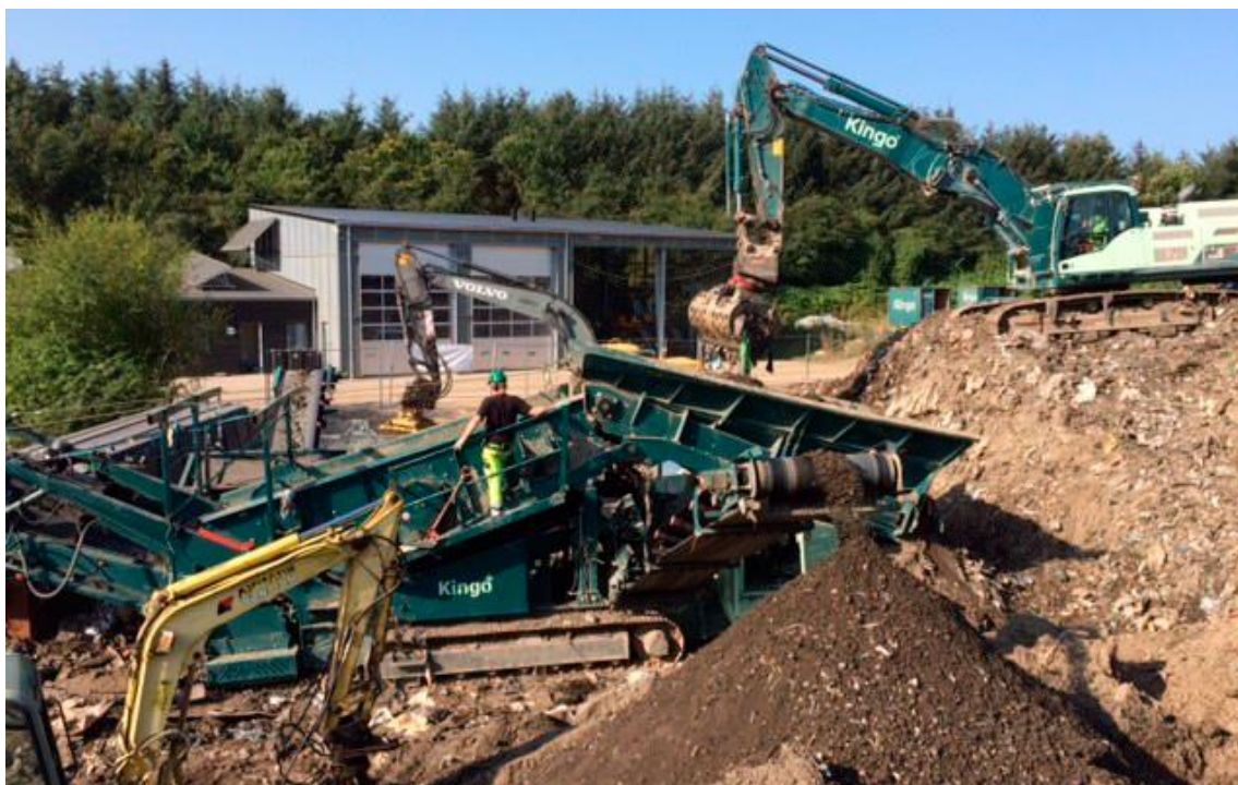
Figur 8 Gravemaskine og rystesorteringsanlæg ved forsøgsprojekt vedrørende LFM af blandet affald på Affaldscenter Skårup (Miljøstyrelsen 2018).
