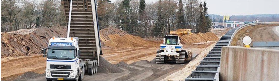
Figur 4. Efter modning og magnetisk separering af slaggerne anvendes dele af materialet som stabilgrus ved vejbygning, www.meldgaard.com .
