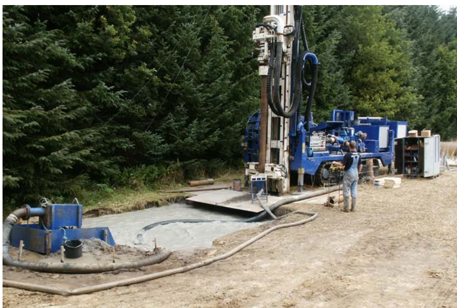
Figur 23: Indretning af boreplads ved skylleboring med lufthæve-metoden. Foto: Tom Martlev Pallesen.
