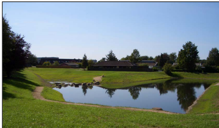
Figur 5. Område ved Ejersmindevej, hvor der førhen var huse, der jævnligt blev oversvømmet, og nu er etableret en sø, der kan tage imod ekstra overfladevand.
