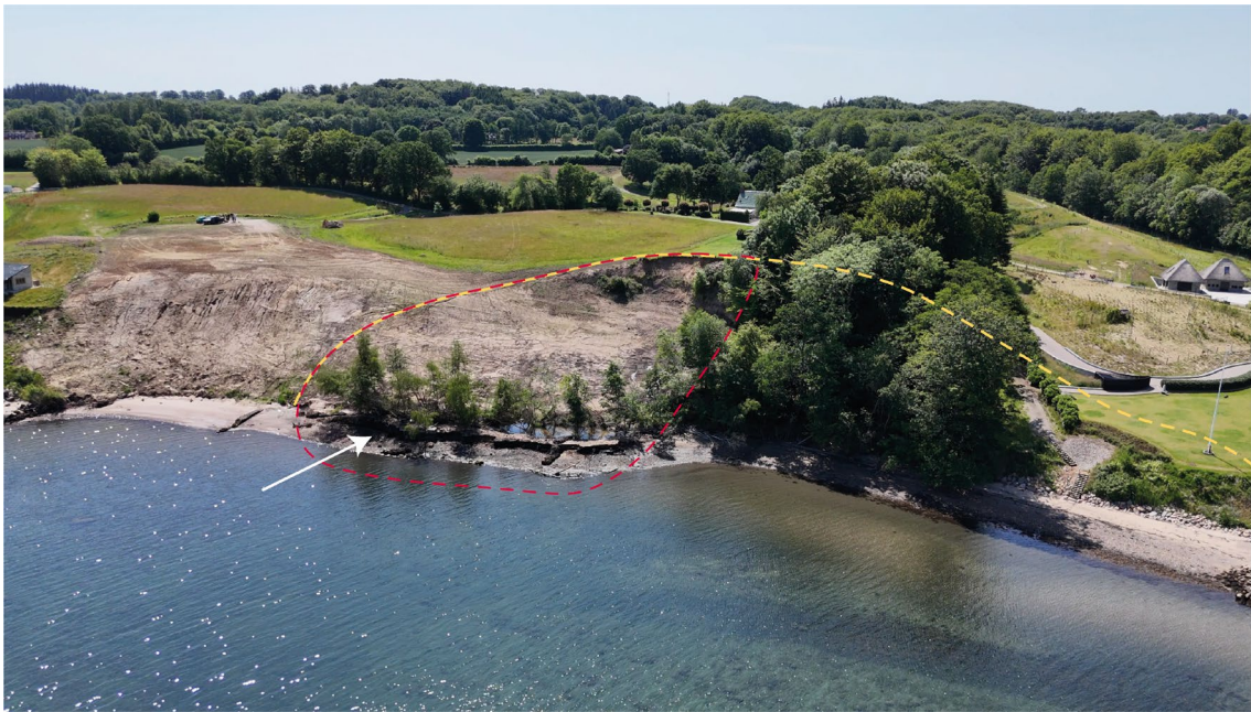
Figur 1. Dronebillede kiggende mod sydvest af området ved Gauerslund Skovvej taget den 20. juni 2025. Bagvæggen af det naturlige landskred er vist med en gul stiplede linje. Området, hvor jordarbejdet har udløst landskredsaktivitet, er markeret med rød stiplede linje. Den udløste skredaktivitet ses blandt andet i form af et 2 m opløft af stranden midt i billedet markeret med en hvid pil. Foto fra GEUS.
