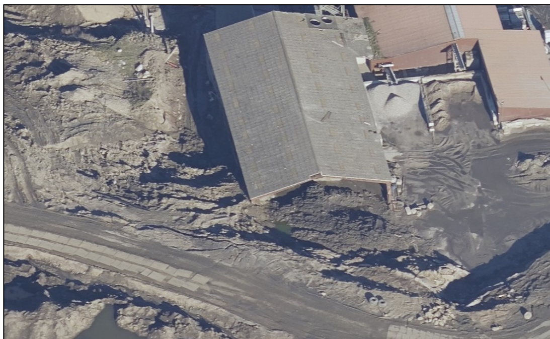
Figur 9. Skråfoto fra 1. april 2023, som viser, hvordan jordskredet har bevæget sig helt ind i en stor lagerhal, som halvanden måned forinden havde fået nedrevet 15 meter af dets vestlige ende. Synsretningen er mod øst.
