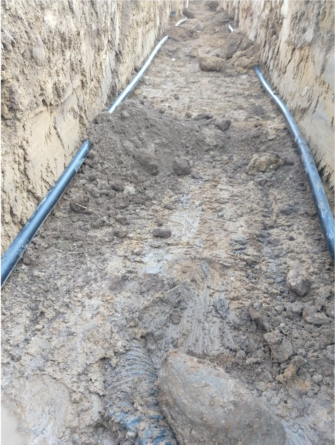
Figur 27. Bund af udgravning til jordvarmeslanger, Enner By. Her ses stærkt siltet moræneler, der mod toppen bliver lamineret og indeholder færre sten.
