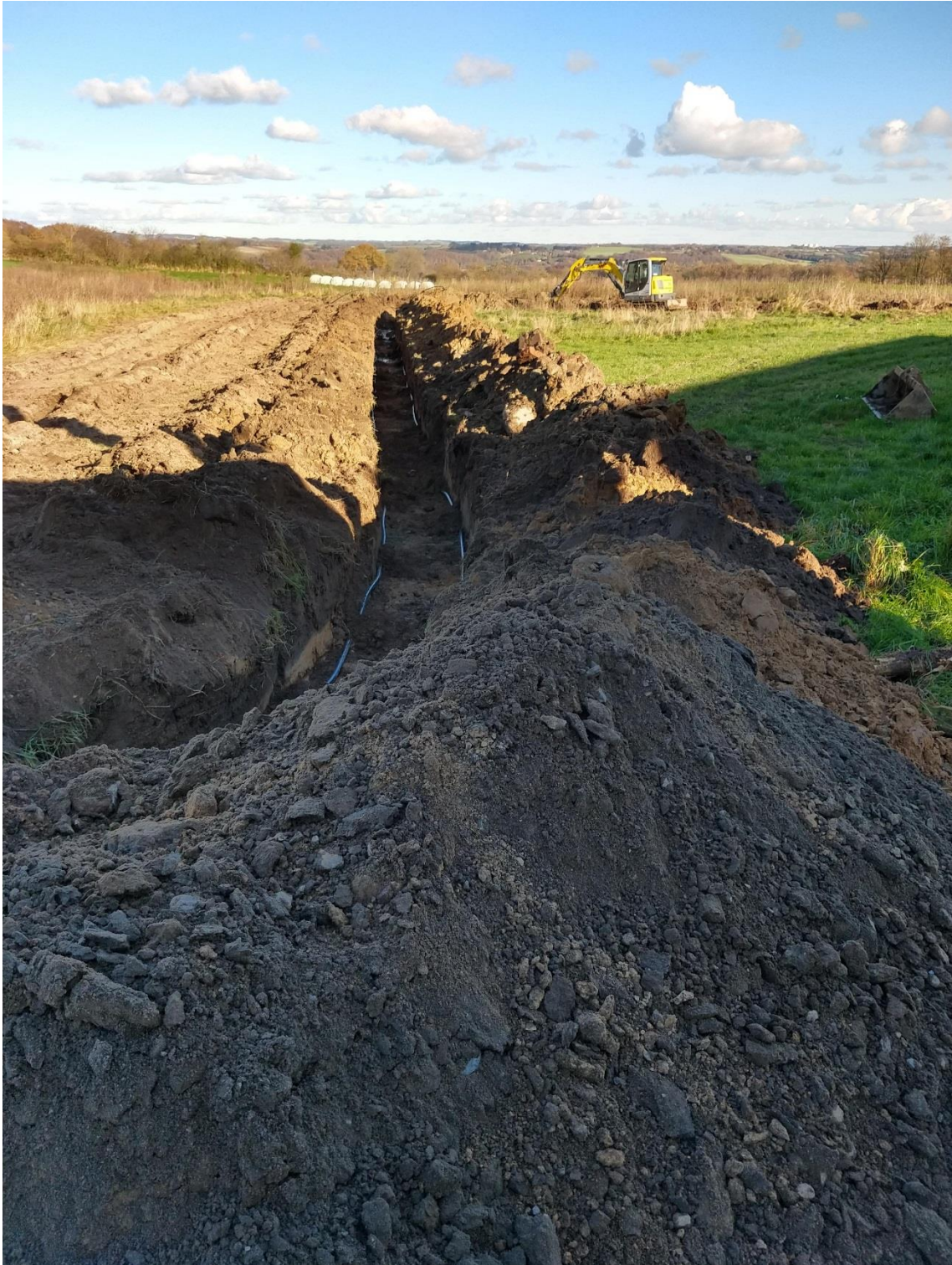
Figur 26. Udgravning til jordvarmeanlæg i Enner By. I horisonten ses nordflanken af Hansted Ådal.
