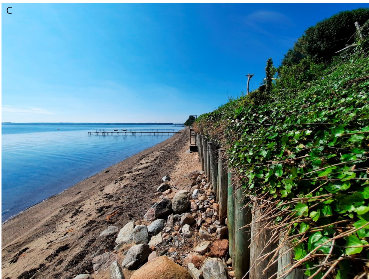
Fig. 7. (denne og foregående side). Feltbilleder fra Svingetskreddet. A) Huset Kildevej 14 med en blød bule i græsset der skyldes skredaktivitet. Huset er lagt på en jernramme så det ikke tager skade af skredbevægelse. B) Huset ved Niels Pedersensvej 43 med sætningsskader. Læg mærke til hvordan husets tag, der i sin tid er anlagt vandret, hælder i forhold til den vandrette horisont. C) Kystsikring nedenfor husene ved Anemonevej. Telefonpælene hælder lidt mod kysten, hvilket kan være tegn på skredaktivitet.
