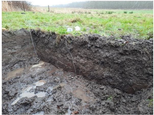
Installationsudgravninger til sugecelle B1 (venstre) og B2 (højre)
