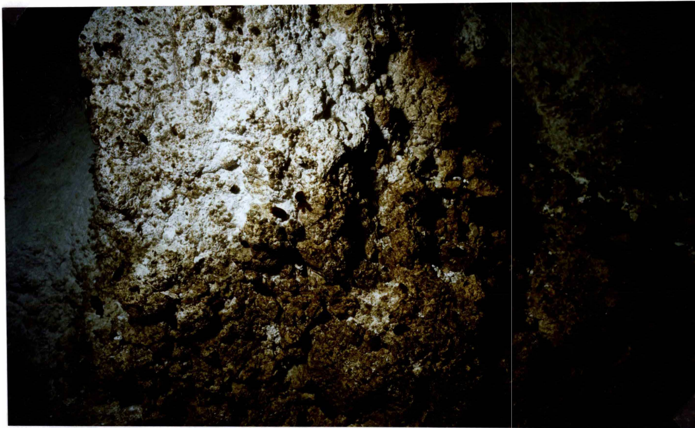
Figur 10. Overgang mellem stærkt hærtnet koralkalk (brunt) og uhærtnet slamkalk (hvidt) i den vestlige væg.
