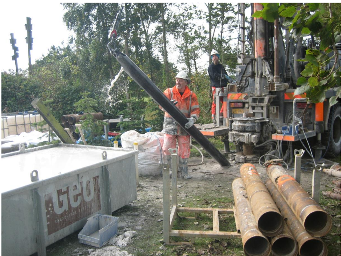
Figur 10. Såvel i boring 242.394 som 242.395 blev der boret med sandspand i skrivekridtet. På billedet er sandspanden lige blevet trukket op af boring 242.395, og kridtmudderet er parat til at blive hældt ud i slæmmekarret.
