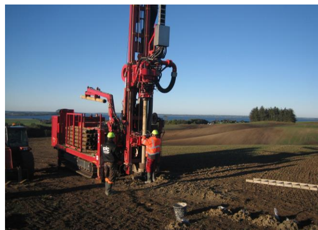
Figur 35. Gribekransen på boreriggen ses her efter den blev sat i stand på det lokale smedeværksted på Fur. Gribekransen holder og roterer bore-rørene under boringen. Under bore-arbejdet ved BH2 var kransens styre-stænger drejet skæve og metaltræt-hed havde fået dele af borehoved til at sprække. Herunder til højre ses boreriggen i funktion ved BH4. Be-mærk udlægget af prøver for hver meter ved siden af spanden.
