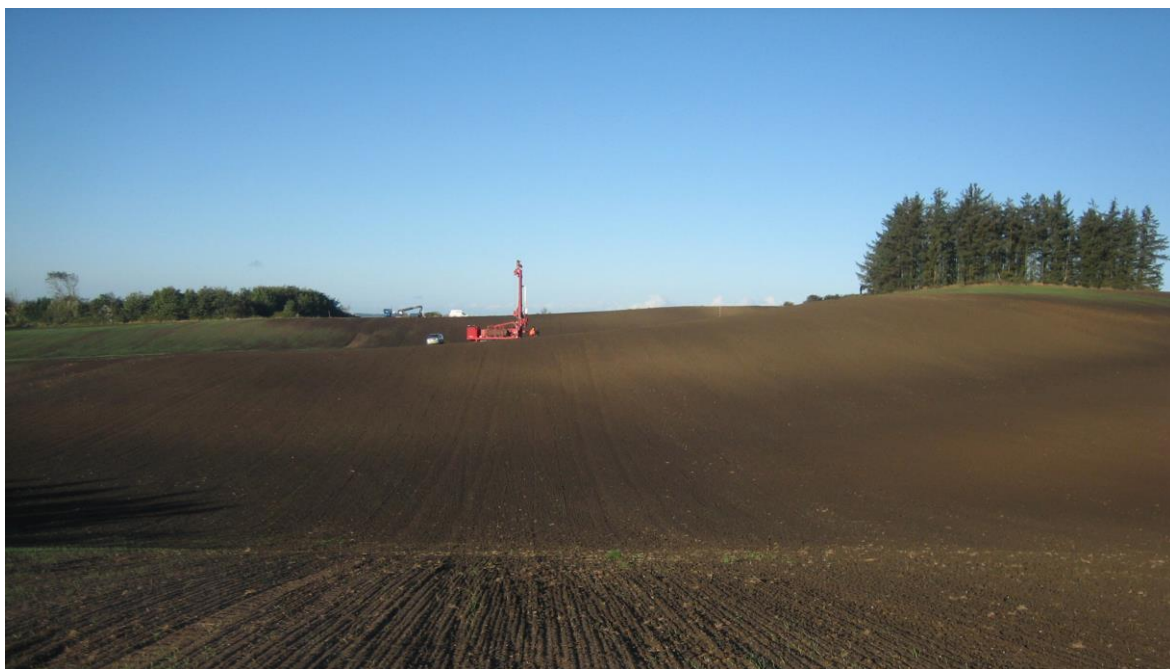
Figur 36. Boreriggen opstillet ved BH3 midtvejs mellem graverenderne GR2 og GR3.
