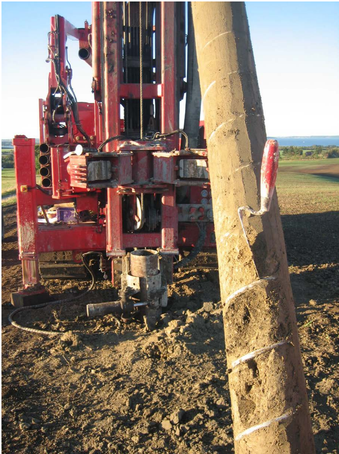
Figur 37. Snegleboringen med opboret materiale fra ca. 17,5 meters dybde i borehul BH4 i Elvergård feltet. Bemærk den brokkede karakter af borematerialet, hvor klaster af moler (gult) er opblandet i askesandet (sort) fra askelag -13. Breccieringen er delvis skabt under boringsrotationen.
