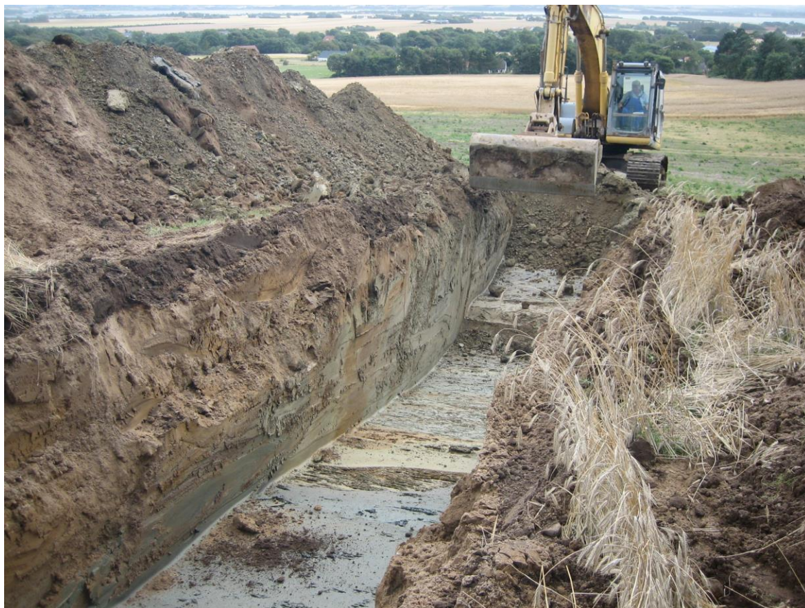
Figur 15. Udgravning af graverende GR2. Da billedet blev taget var gravningen lige kommet igennem det plastiske Røsnæs-ler.
