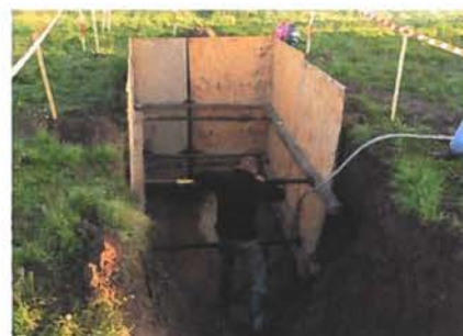
Afstivning i udgravning hvorfra der "bores". Foto fra en tidligere udført horisontal boring.
