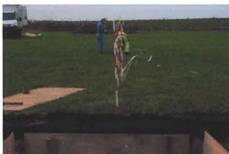
Retning fra den udgravning hvor der "bores".
