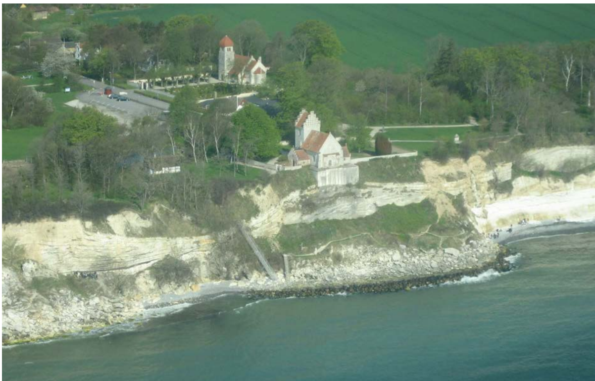
Figur 16. Klippeskredet ved Højerup gamle kirke. Toppen af skredmassen ligger i en højde af c. 15 m o.h., og tåen af skredet er kystbeskyttet mod erosion ved hjælp af "importerede" blokke. Den nye kirke i Højerup blev bygget i 1913, idet den lokale befolkning frygtede en kollaps af overhængen, som den gamle kirke lå oven på (sammenlign med Fig. 17).
