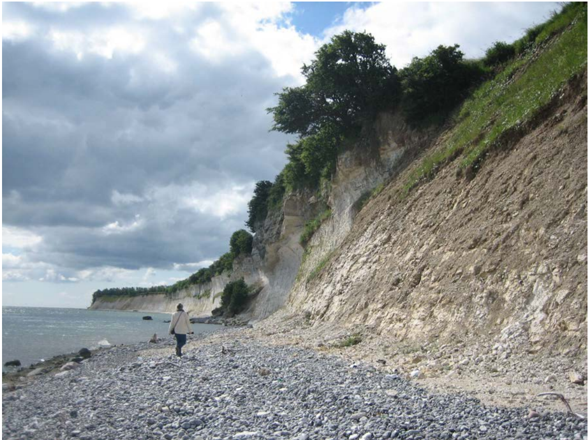
Figur 26. Kysten mellem Holtug kalkgrav og Bøgeskov Havn, hvor tykkelsen af moræneler over bryozokalken medfører kombinerede jordskred med klippefald. Bemærk strandens dominans af flinterullesten og de små taluskegler ved foden af klinten, som skyldes den almindelige erosion af stenras på grund af vinterens frost og tør, samt sommerens vekslen mellem fugtmætning og udtørring.
