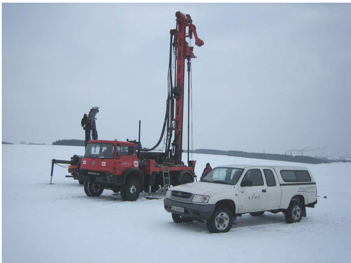
Figur 24. Opstilling af boreriggen ved boring DGU nr.68.1137 syd for Nyborggård i februar 2010. I baggrunden ses røgen fra en af fabrikkerne, der producerer Leca granulat.
