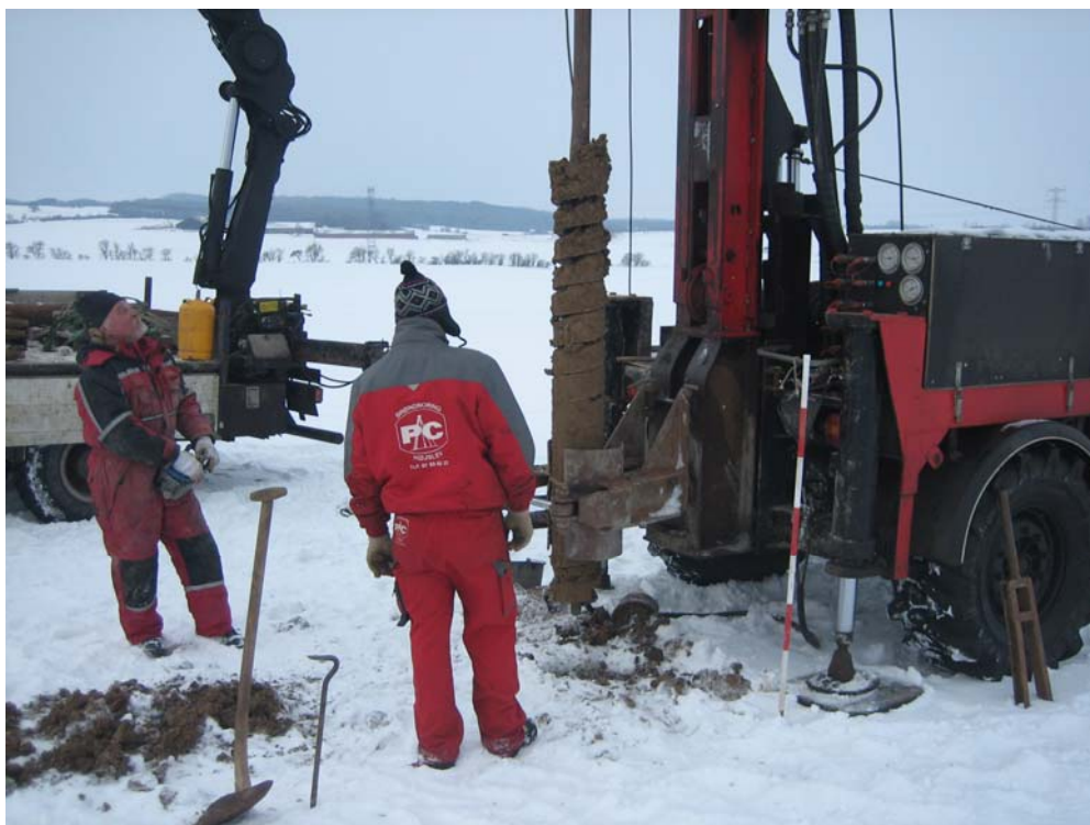
Figur 11. Snegleboring gennem øvre moræneler Nyborggård boring 68.1137.
