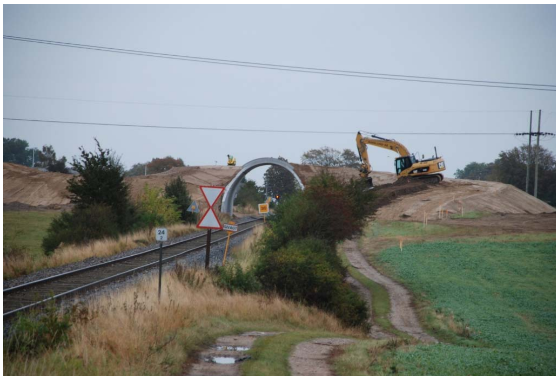
Ny bro ved markvej over jernbane
