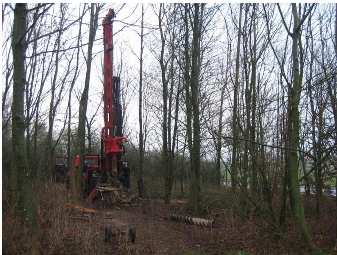
Figur 2. Boreopstilling ca. 40 m nord for det Gule Hus. De ophentede kernerør blev lagt på række mellem træerne til højre, efter pvc rørene var blevet opskåret, så en opmåling kunne foretages direkte på borestedet.
