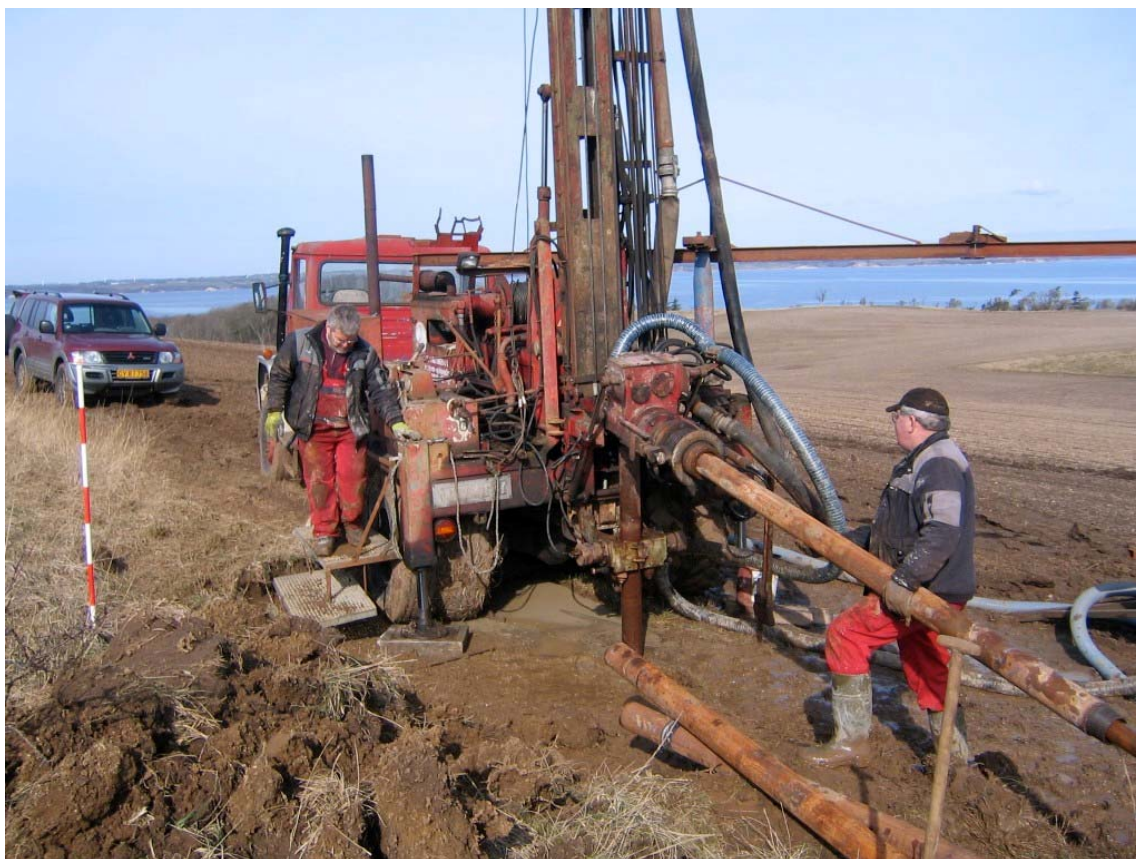
Figur 9. Molerundersøgelsesboring udført ved hjælp af Højslev metoden. Her er et nyt rør på 3 meters længde ved at blive monteret oven på den øvrige borestamme ved udførslen af boring DGU nr. 30.4000.
