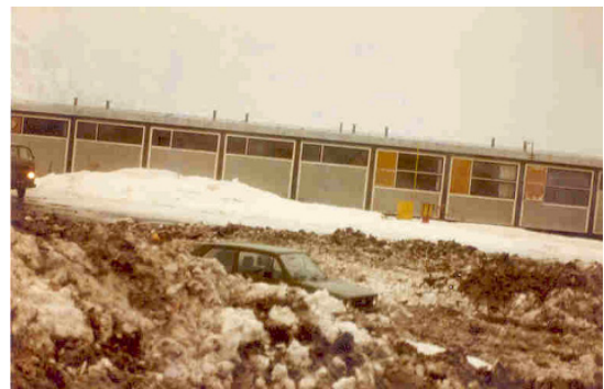
Figur 5. Snemasser som overskred og passerede bygning 191.
