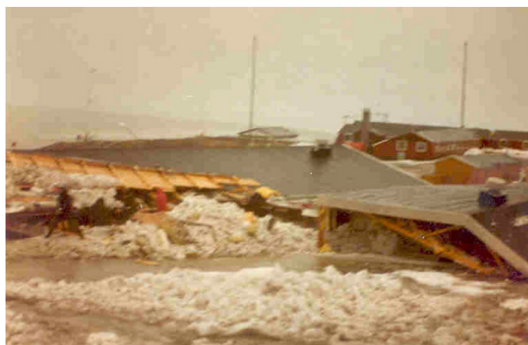
Figur 2. Udsnit af hvor lavinen i 1983 ramte bygning 191. Bemærk den mørke sne, det afbrækkede tagskæg samt den "lave" snehøjde. Sneen i lavinen har været meget viskøs, har overskredet bygningen og er derefter hurtigt sunket sammen som følge af dræning af vand fra den overmættede sne.
