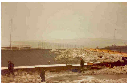
Figur 6. Den ødelagte bygning. Bemærk de store vandmængder.
