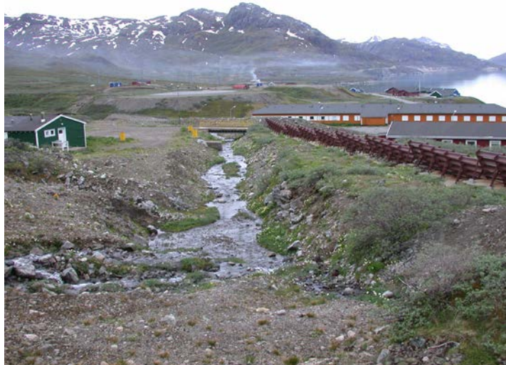
Figur 14. Renden set ovenfra. Bemærk det smalle forløb og hindringen fra hhv. kloak og bro.
