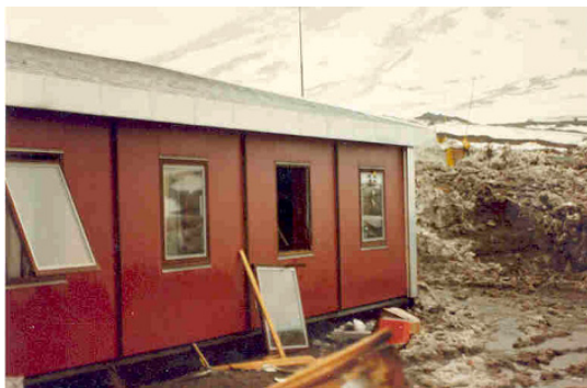
Figur 4. Aflejrede snemasser ved den sydlige ende af bygning 191.
