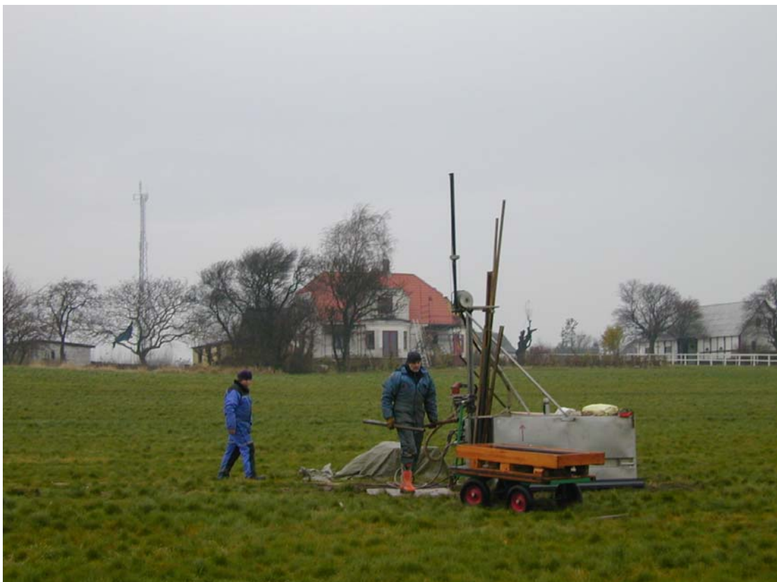
Figur 2. Boring 247.609 under udførelse. Julehøj ses i baggrunden.
