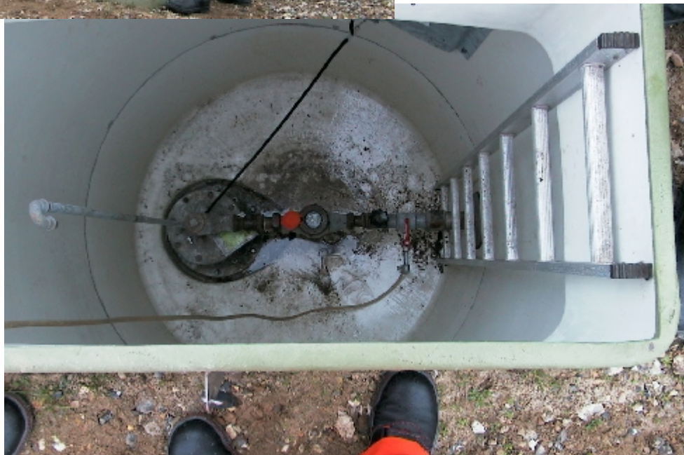
Figur 2. Boring DGU nr. 47.767 beliggende centralt på gaslager området. Råvandshane er forsynet med 1/2" gevind. En eller flere haner i administrationsbygningen åbnes for at sikre, at pumpen arbejder mens der udtages prøver.
