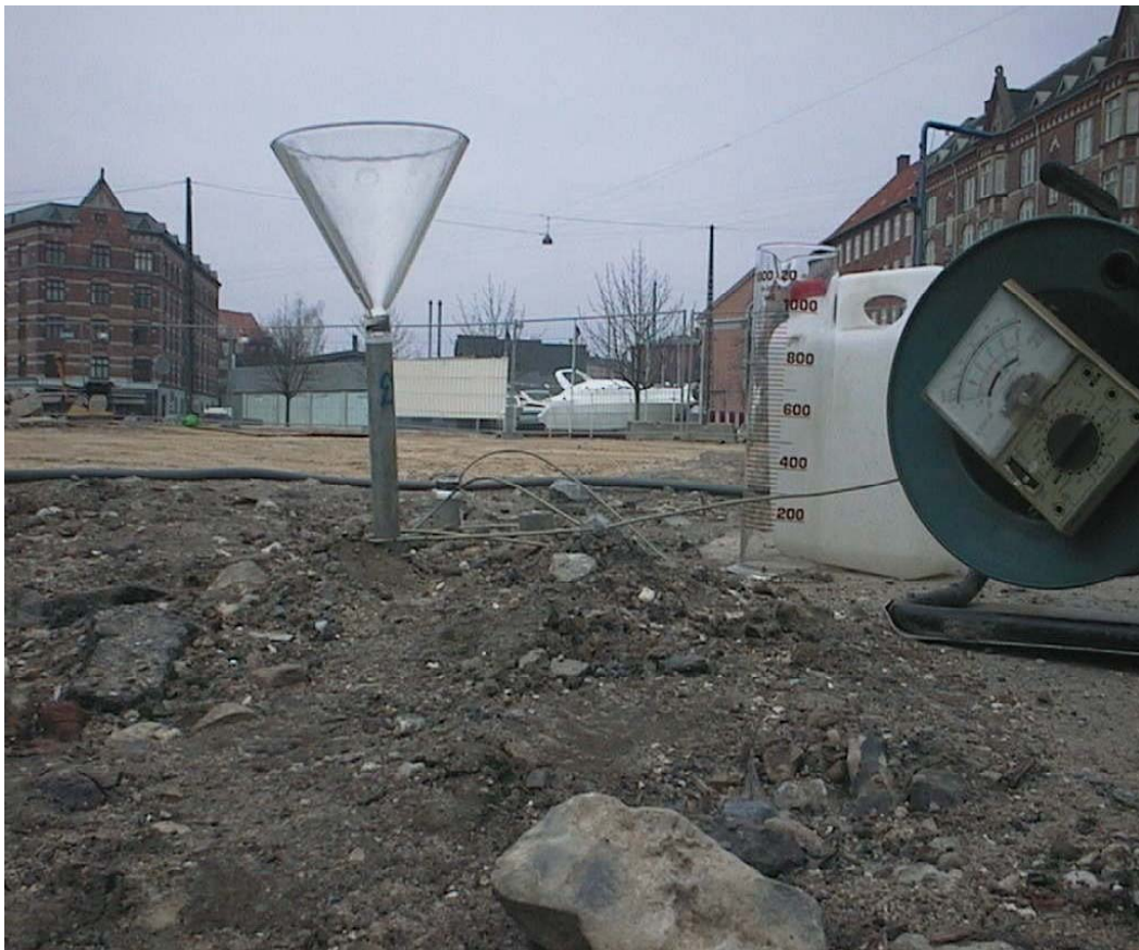
Figur 101. Slugtestene blev udført ved spontant at tilføre 1l vand til jernrørene via en tragt.
