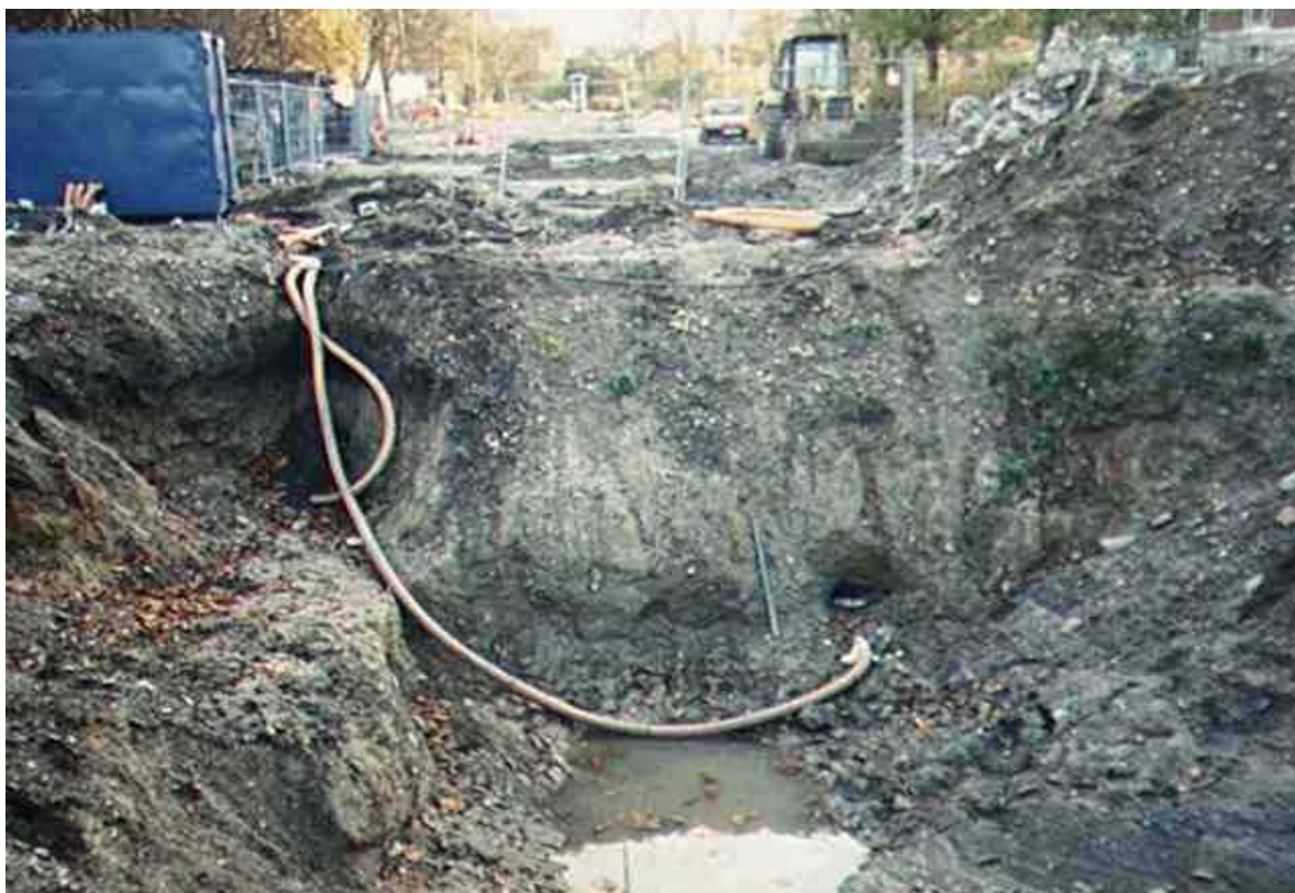
Figur 26. Forbindelsesslangerne mellem de to vandrette filterstrækninger og manøvrecontaineren er ført gennem beskyttende drænslinger til containeren.
