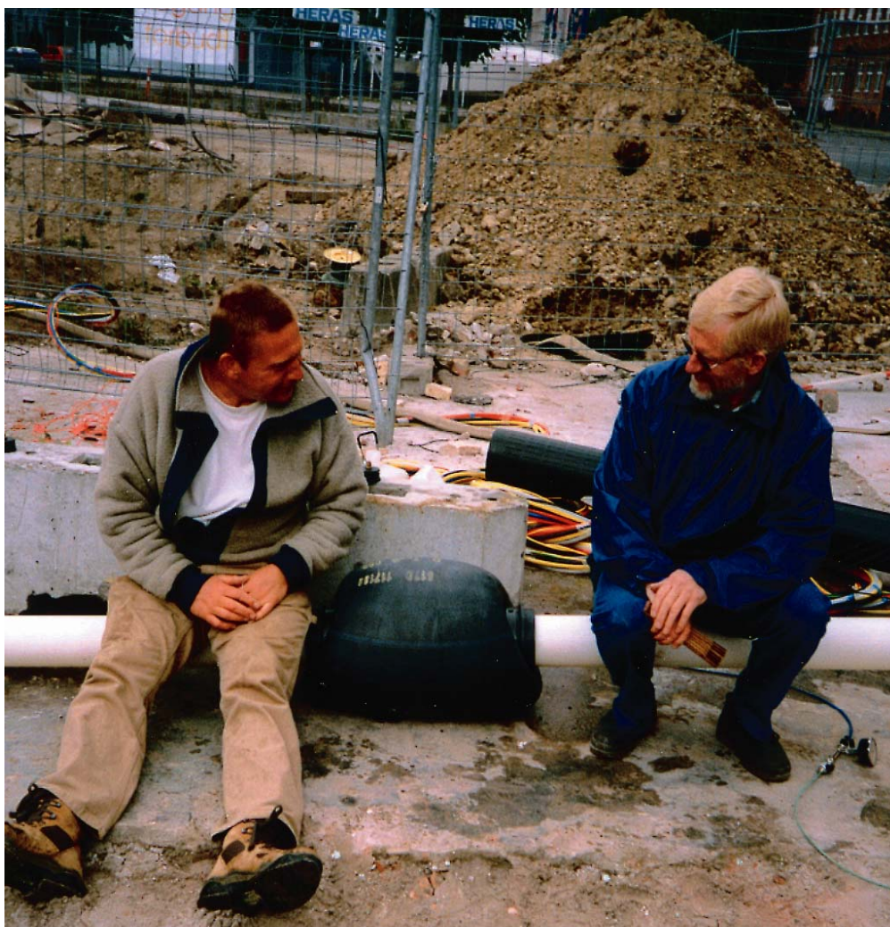
Figur 23. Pakker lavet af et stykke traktorslange. Der skal to mands vægt på filterrøret til den øvre vandrette boring for at gøre pakkeren tilnærmelsesvis symmetrisk.
