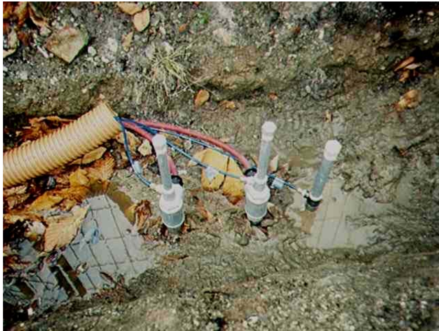
Figur 29. Rede 3 - færdigmonteret i rende før tilkastning.
