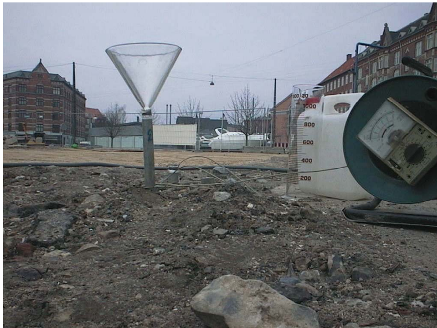
Figur 35. Slugtestene blev udført ved spontant at tilføre 1l vand til jernrørene via en tragt.
