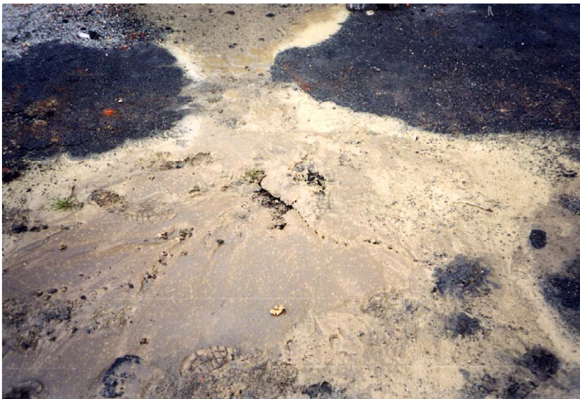
Figur 16. Hydraulisk frakturering af gammel asfaltbelægning i terræn ved etablering af den øvre vandrette boring.
