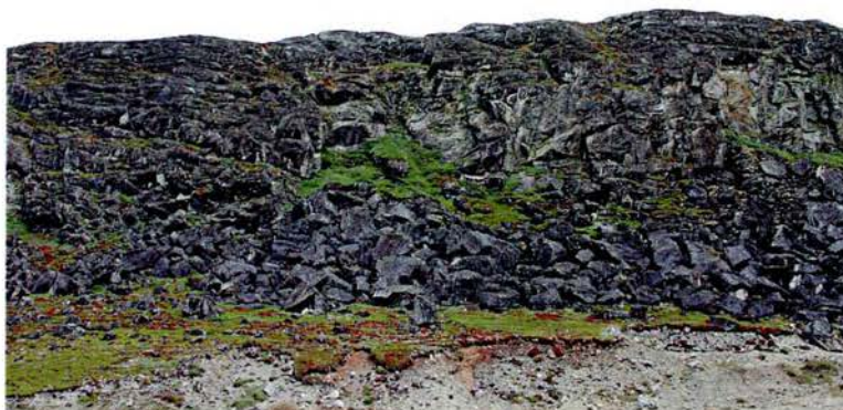
Figur 13. Foto af den sydøstlige side af fjeldet hvor der er projekteret tunnel til Qingonput. De lagparallelle sprækker dykker stejlt ind i fjeldvæggen og forårsager blokfald og et overhæng på en del af fladerne på fjeldsiden
