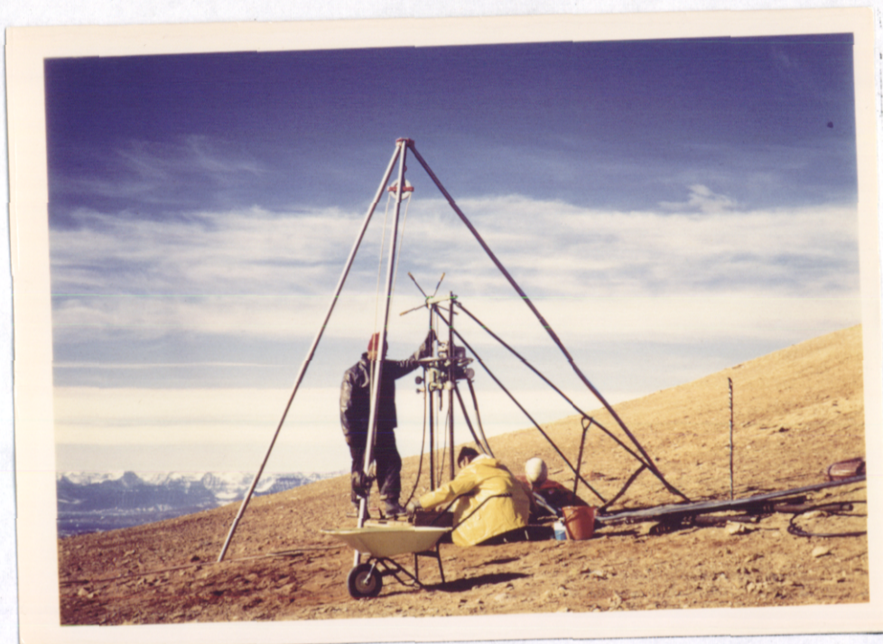
Foto nr. 5. Bohrgerät Winkie im Einsatz Bohrloch 2.
